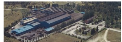
Vista aérea de la planta
