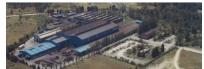
Vista aérea de la planta
