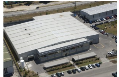
Vista exterior de la nave de MRF
