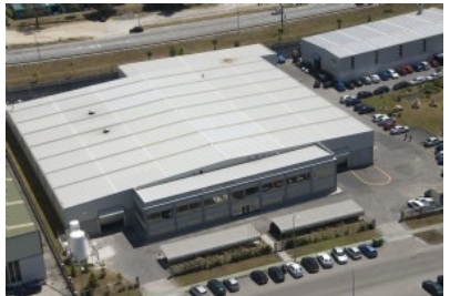
Vista exterior de la nave de MRF
