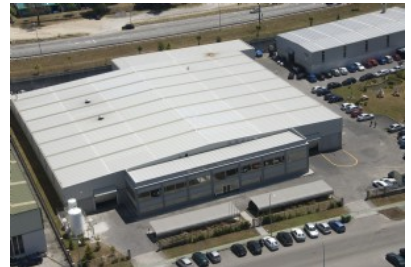
Vista exterior de la nave de MRF
