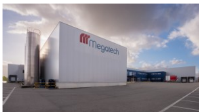
Vista exterior de la planta
