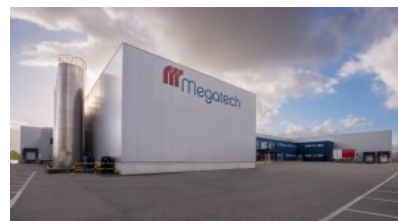
Vista exterior de la planta
